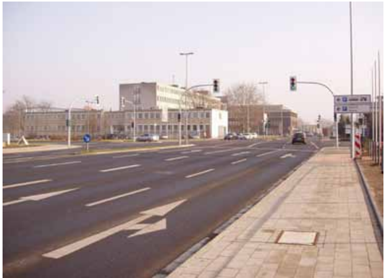
Nach dem Umbau: 2 PKW-Spuren mehr, die Radwege sind verschwunden
